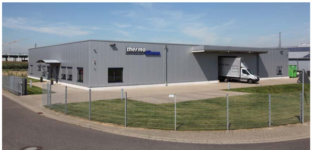
Das Verwaltungs- und Produktionsgebäude von thermodämm in Übach-Palenberg
